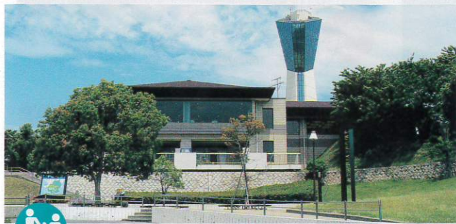
管理棟 レストラン・売店・ロビー・事務所があります。
